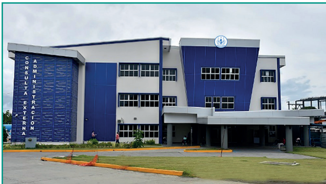
▼ Consulta Externa del Nuevo Hospital Dionisio Arrocha
