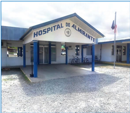
HOSPITAL DE ALMIRANTE
